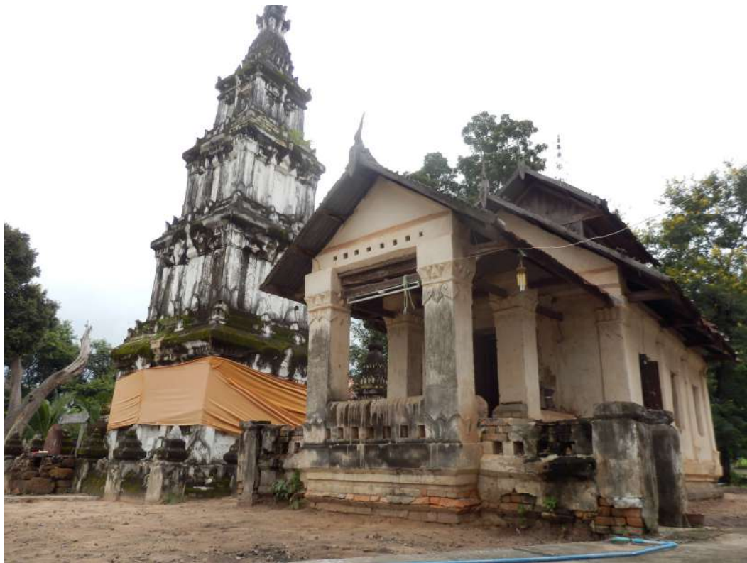
ภาพที่ 5 สภาพโบราณสถาน มุมทิศตะวันตกเฉียงใต้ ก่อนการดำเนินงาน
