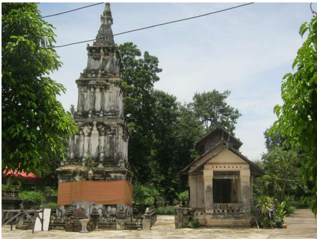
ภาพที่ 3 สภาพโบราณสถาน ด้านทิศตะวันตก ก่อนการดำเนินงาน
