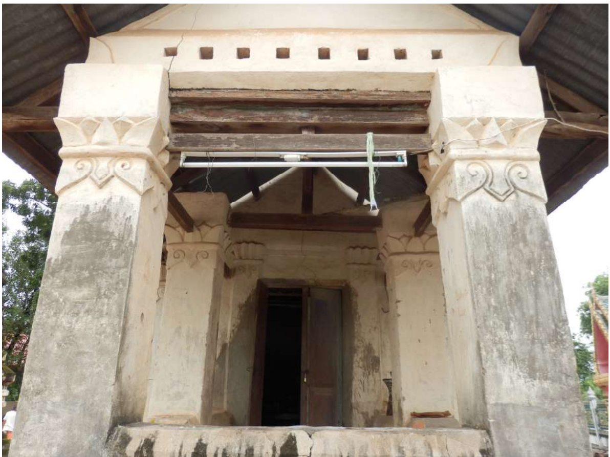
ภาพที่ 22 สภาพเสามุขหน้า มีการประดับลายกลีบบัวปูนปั้นบนหัวเสาและตีนเสา ก่อนการดำเนินงาน
