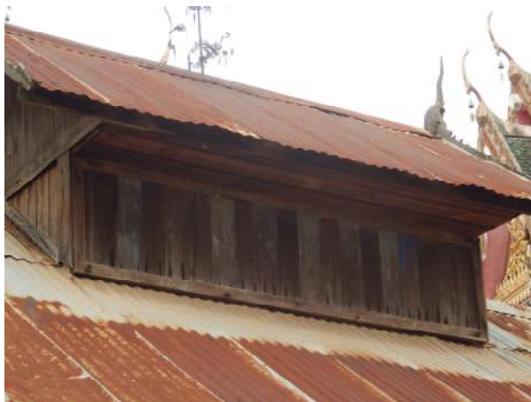
ภาพที่ 18-19 สภาพหลังคาสิมด้านบน มีการยกคอสองของหลังคาขึ้นมาอีกชั้นหนึ่ง มีร่องรอยการทาสีครีมและน้ำเงิน
