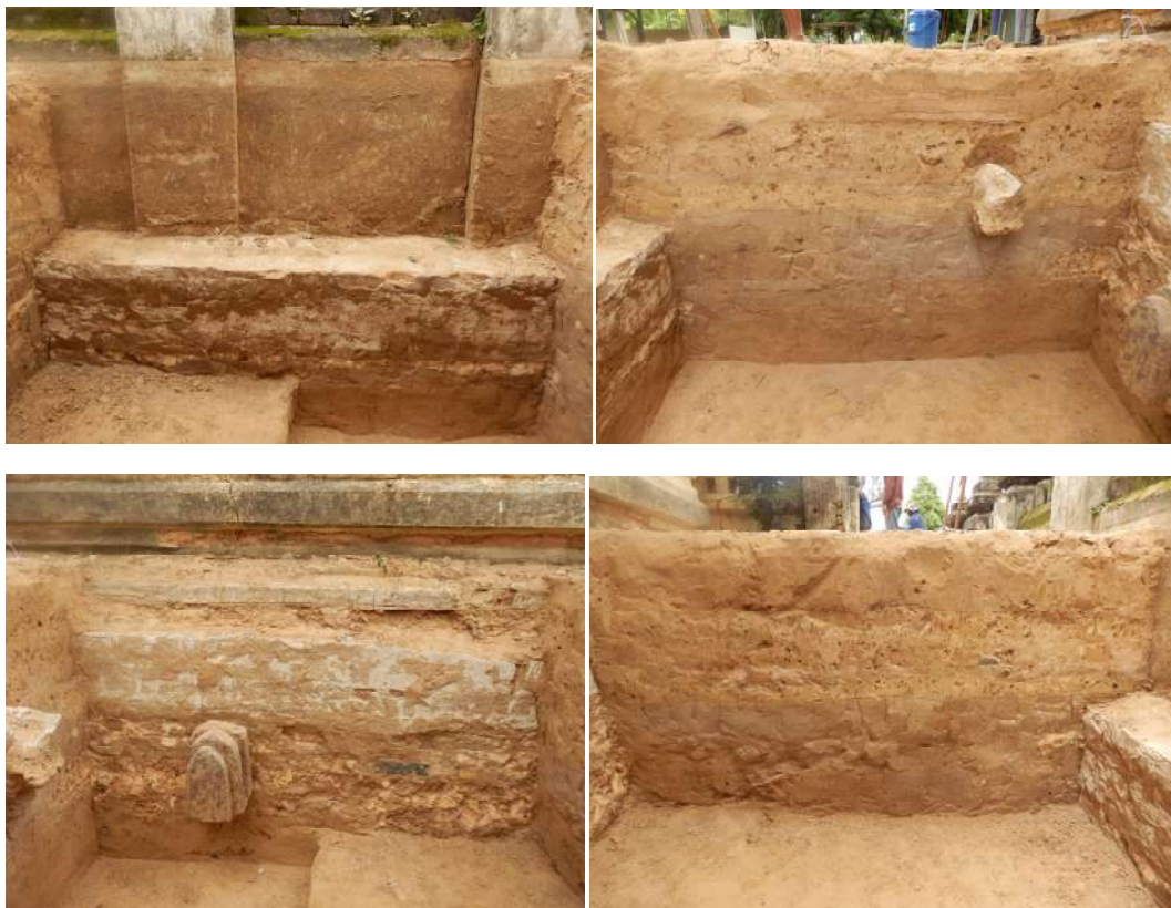
ภาพที่ 92-95 ผังชั้นดิน หลุมขุดตรวจที่ 1 (Trench 1) ด้านทิศเหนือ-ทิศตะวันออก-ทิศใต้-ทิศตะวันตก
