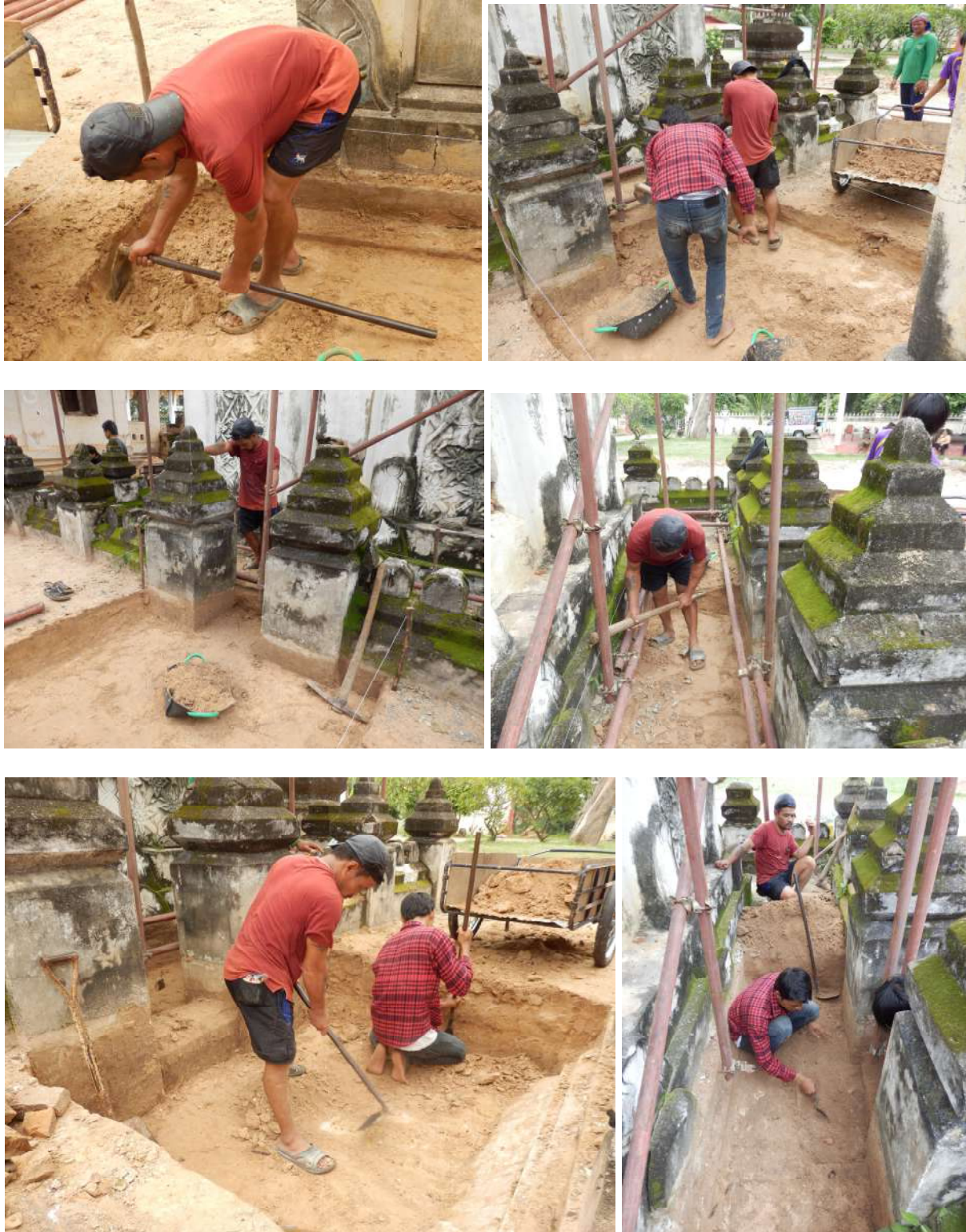
ภาพที่ 96-101 การดำเนินงานขุดตรวจ หลุมขุดตรวจที่ 2 (Trench 2)
