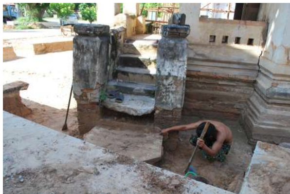
ภาพที่ 145-148 ขณะทำการแยกบันไดและถนน เพื่อหาแนวบันไดเก่า
