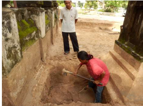
ภาพที่ 155-156 ขณะขุดหลุมทดสอบเพื่อตรวจสอบฐานรากธาตุ (องค์ทิศเหนือ)
