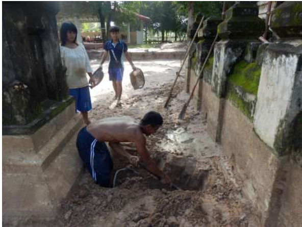
ภาพที่ 155-156 ขณะขุดหลุมทดสอบเพื่อตรวจสอบฐานรากธาตุ (องค์ทิศเหนือ)
